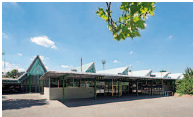
Außenansicht des Glaspalastes – Konstruktion aus Stahl und Glas.
